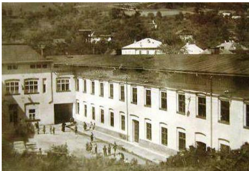
Pôvodný vzhľad budovy, v ktorej dnes sídli naša škola
